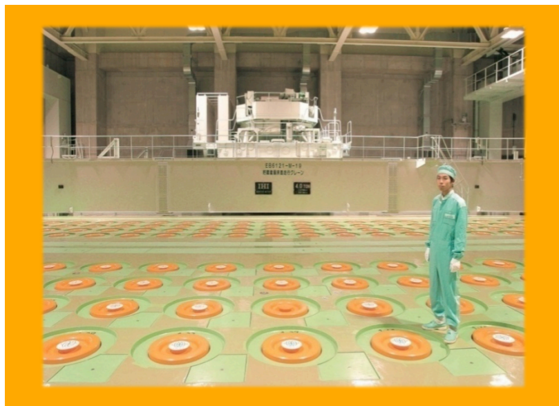
日本原燃(株) 高レベル放射性廃棄物貯蔵管理センター (青森県六ヶ所村) 写真提供: 日本原燃(株)
