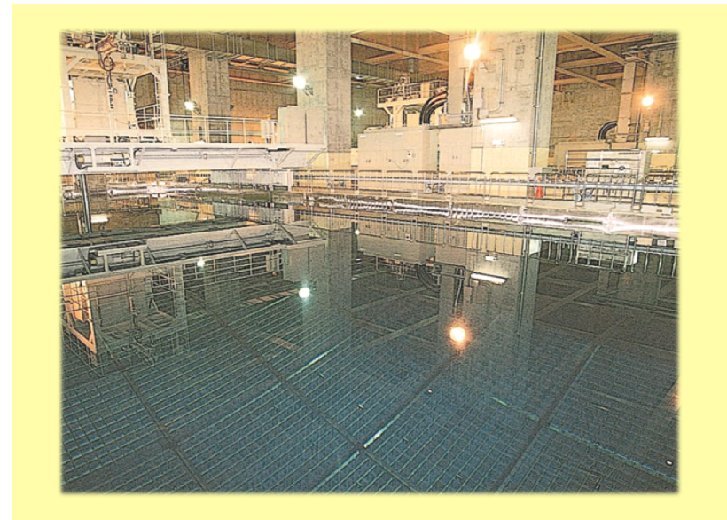
日本原燃(株) 使用済燃料貯蔵プール
