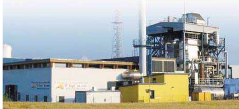
木材ガス化プラント
