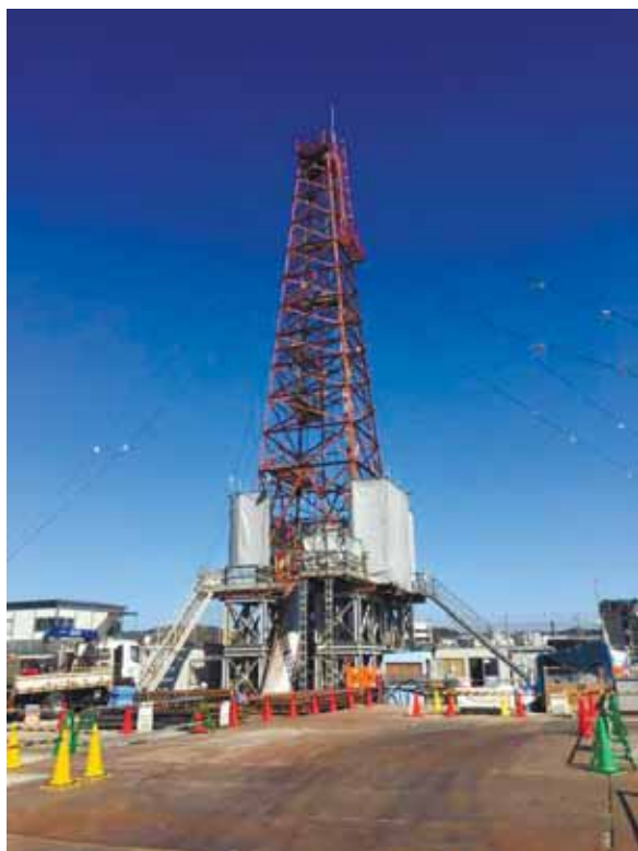
ボーリング調査の外観 (やぐら)
