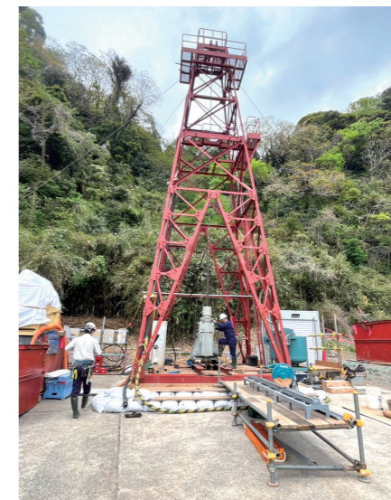
ボーリング試験の様子(やぐらの高さ約13m)
