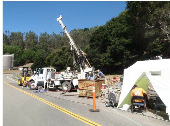
図-2 傾斜ボーリング調査の様子
